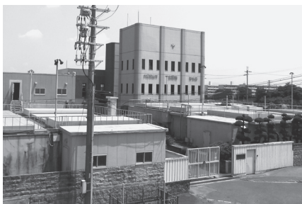
太満池北側にある浄水場
