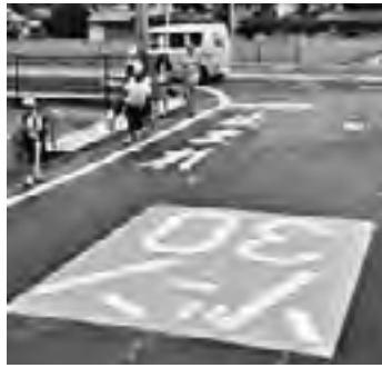
路面標示の例【ゾーン30】
