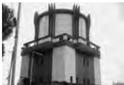
今熊地区低区配水池
