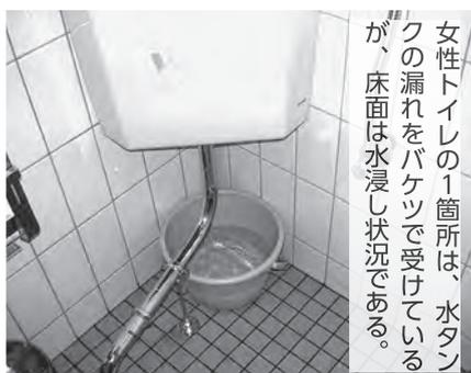
女性トイレの1箇所は、水タンクの漏れをバケツで受けているが、床面は水浸し状況である。
