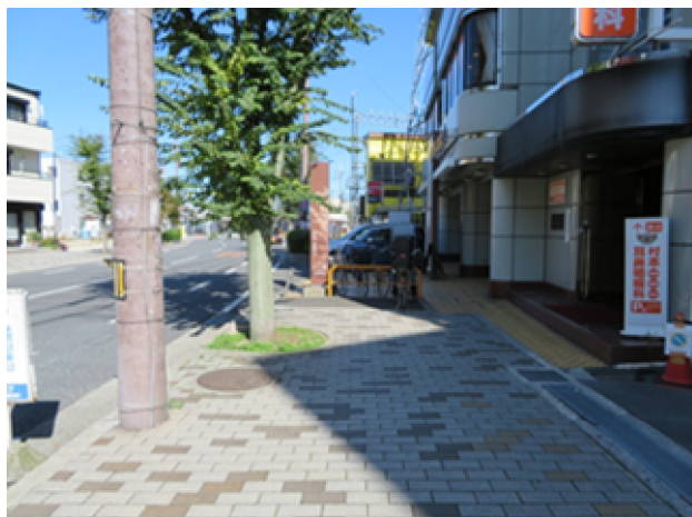
途中で途切れている歩道
