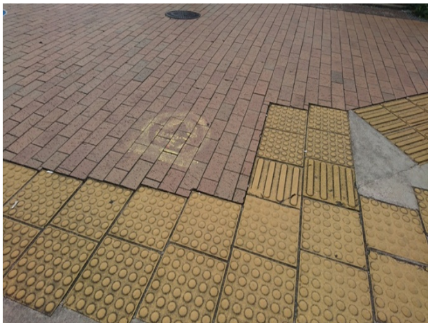
点字ブロック確認
