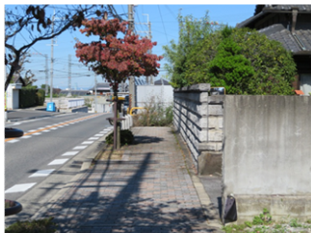
途中で途切れている歩道
