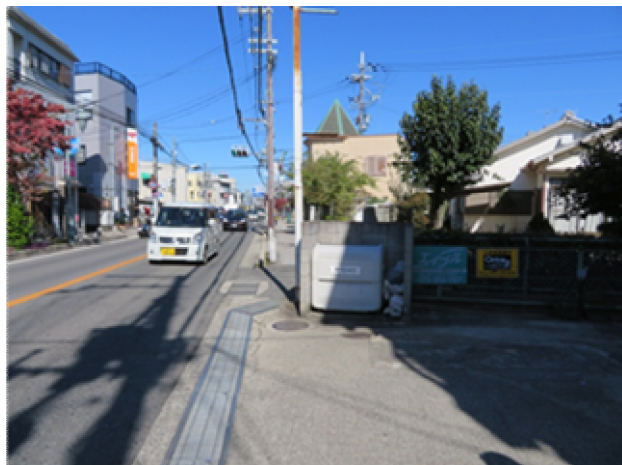
途中で途切れている歩道
