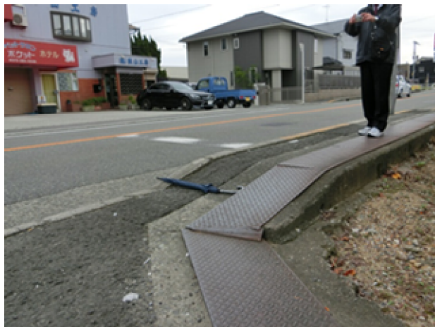
水路の鉄板（池之原南）
