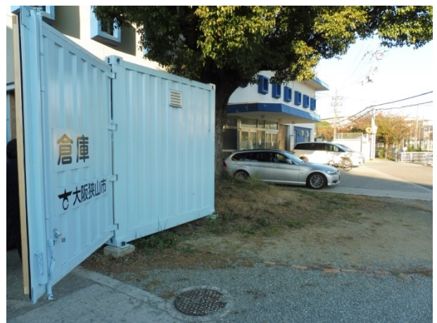
狭山中学校防災倉庫
