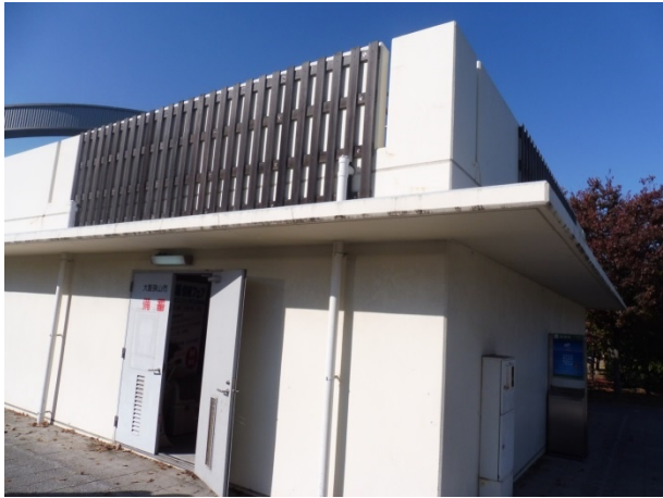
さやか公園防災倉庫
