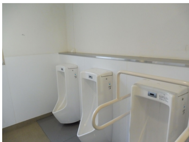
南中学校校舎内トイレ
