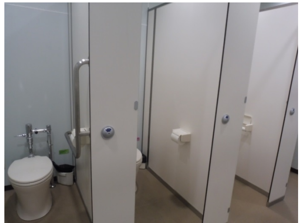
狭山中学校校舎トイレ
