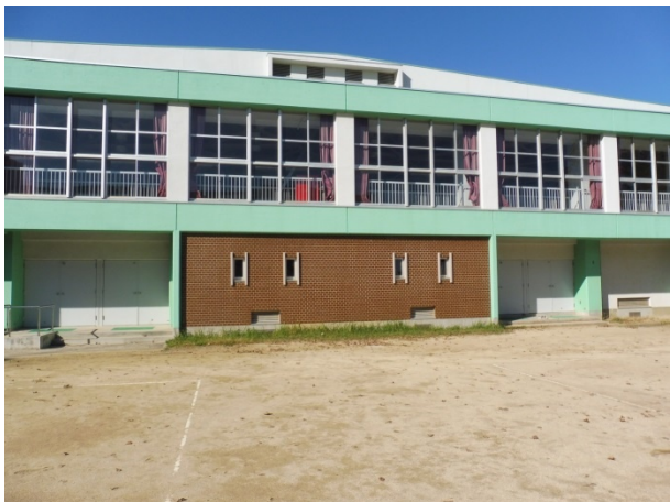
南中学校体育館
