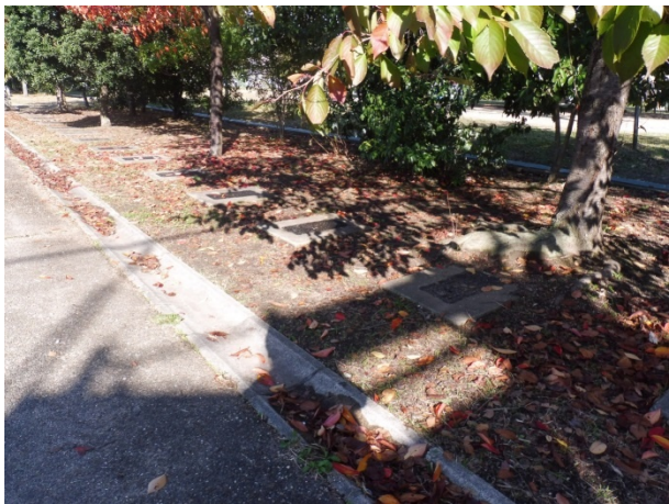
さやか公園災害用マンホールトイレ
