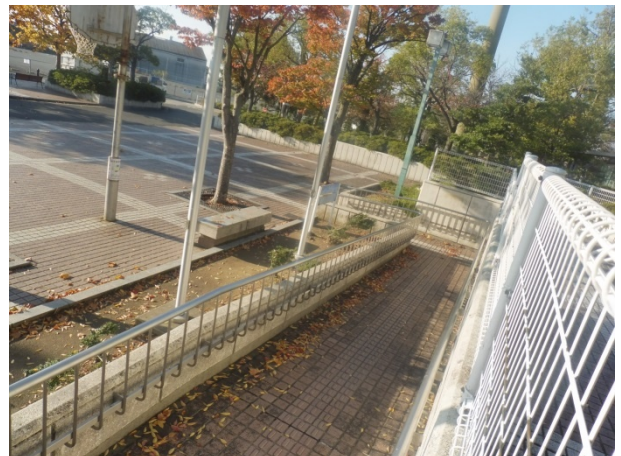
総合体育館スロープ
