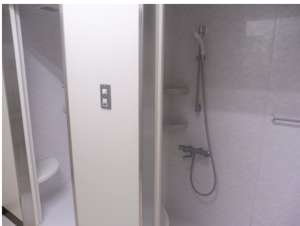
総合体育館シャワー室
