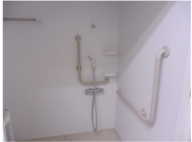
総合体育館シャワー室
