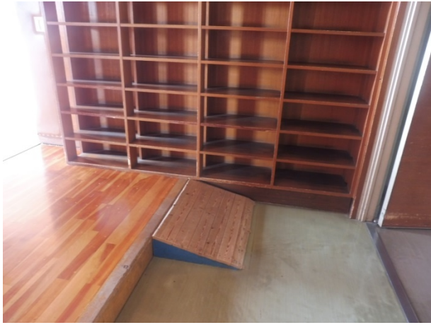
総合体育館入口スロープ
