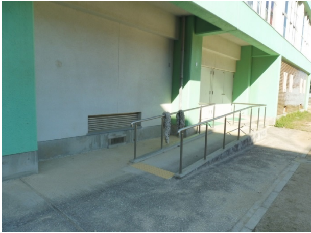
南中学校体育館スロープ
