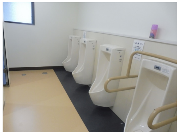
総合体育館トイレ
