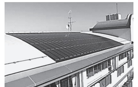
太陽光発電を屋根に設置した例
